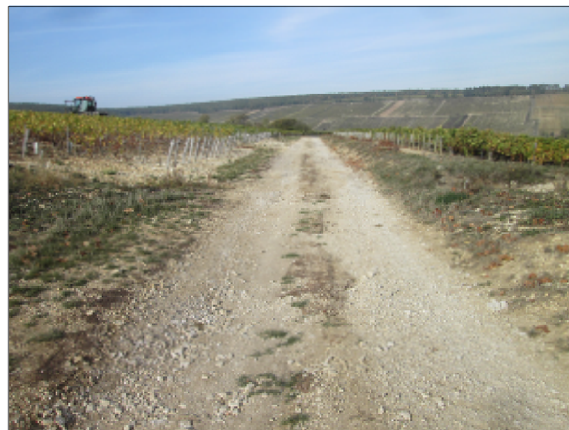
Photo n°35 : Vue du 2 ème chemin de traverse avec bourrelet empêchant les ruissellements vers l'aval
