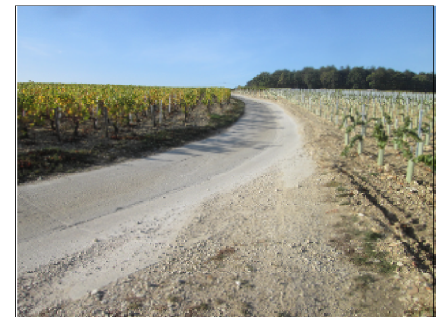
Photo n°17 : Vue du chemin imperméabilisé avec concentration des écoulements au centre
