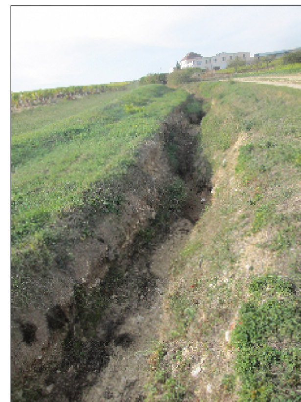
Photo n°39 : Vue du fossé alimentant la noue
