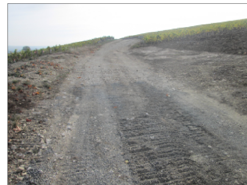
Photo n°34 : Chemin de traverse avec bourrelet empêchant les ruissellements vers l'aval et les dirigeant vers l'Ecopal
