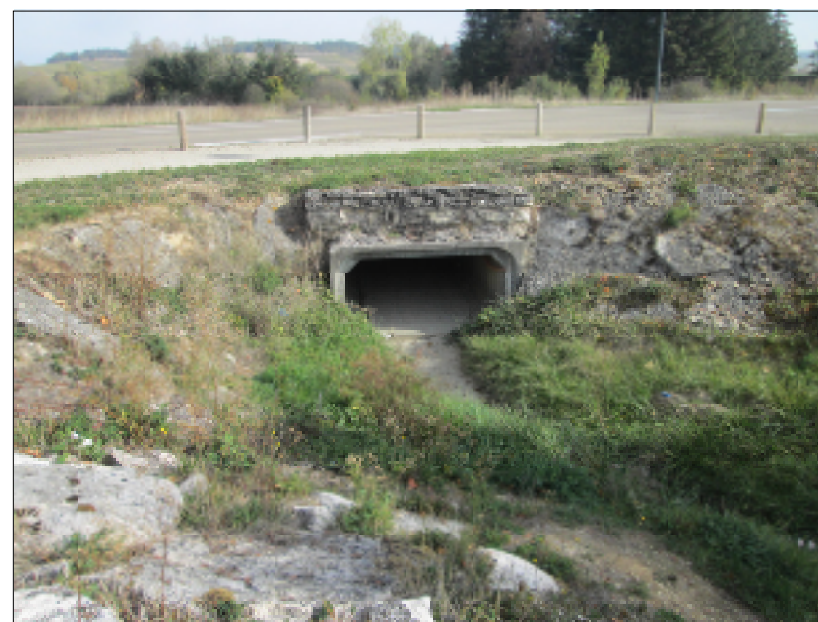
Photo n°41 : Vue du passage busé sous la voirie
