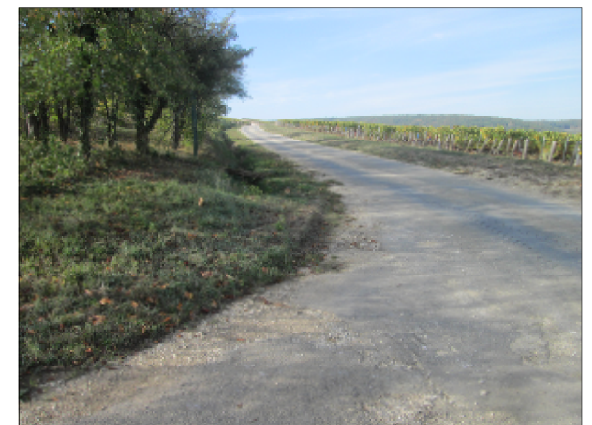
Photo n°26 : Vue du chemin vers l'amont
