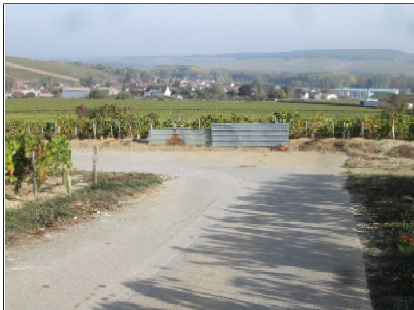
Photo n°21 : Vue du chemin imperméabilisé avec concentration des écoulements au centre côté Ouest
