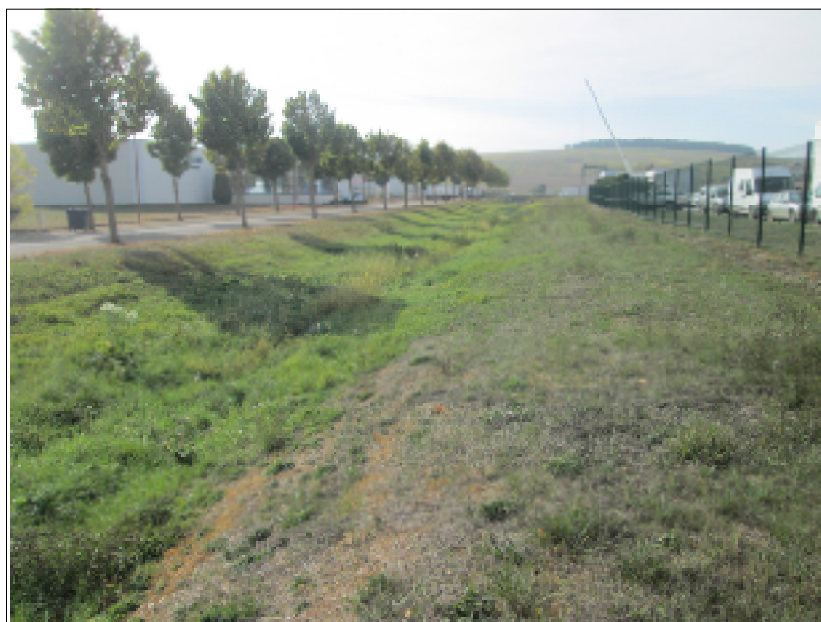
Photo n°40 : Vue de la noue depuis la route en aval de la ZAC
