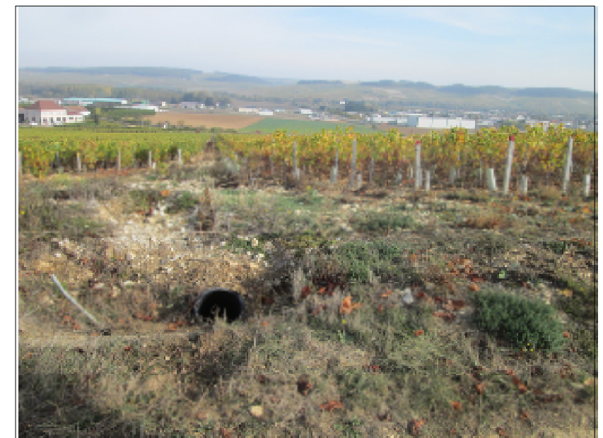
Photo n°36 : Entrée de l'Ecopal au niveau du 2 ème chemin de traverse
