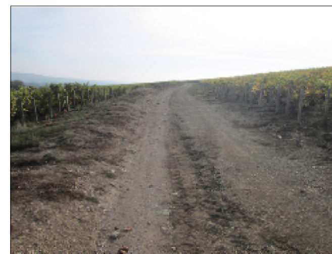
Photo n°32 : Chemin de traverse avec bourrelet empêchant les ruissellements vers l'aval
