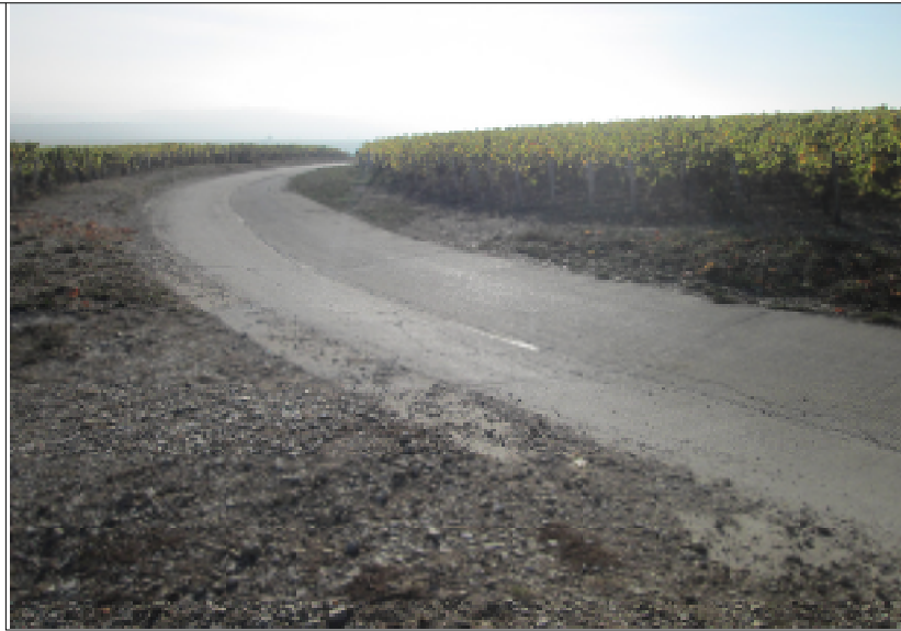
Photo n°18 : Vue du chemin imperméabilisé avec concentration des écoulements au centre
